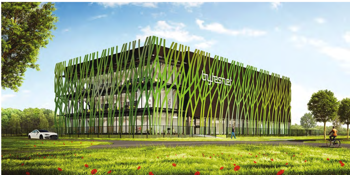
Referentiebeeld: datacenter Bytesnet op het Zernikecomplex in Groningen (bron: website www.bytesnet.nl ).
